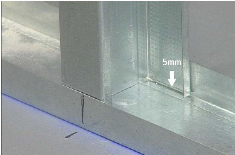
**Corte os montantes 5mm menor que a altura da parede**
