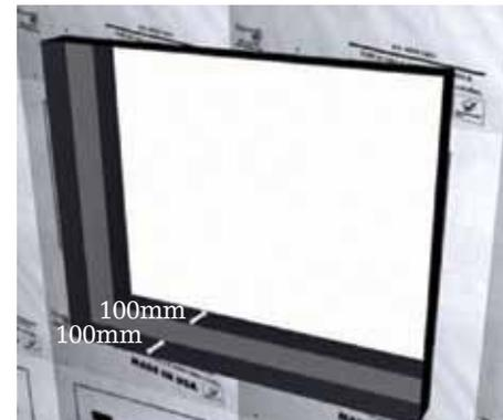
18. A Fita adesiva asfáltica impermeável, deve ser aplicada na parte interna da abertura de tal maneira que fiquem abas de no mínimo 10cm, tanto no lado interno como externo da parede, que posteriormente serão dobradas e coladas na face do parede. - Figura 5.
