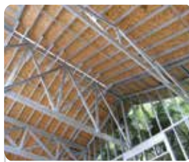
Cobertura - vista interna
